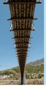
桃介橋は大正11年9月に完成。木曽川の水力発電開発に力を注いだ大同電力(福 沢桃介社長)が読書発電所(大正12年完成)建設の資材運搬路として架けたものです。 全長247m、幅2.7mで、この付近では最大川幅のところにあり、美しく雄大な
