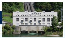
大正10年11月から12年12月にかけて大同電力株式会社によって、当時最大出力4万 7百キロワットの水路式発電所として建設されました。当時は大同電力社長福沢桃介が、「一 河川一会社主義」を主張して木曽川に次々と発電所を建設していましたが、読書発電所の完成 は、当時の水路式発電所の金字塔ともいうべきものでした。
