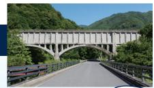
読書発電所への導水路のうち、柿其川を渡る鉄筋コンクリート造りの 水路橋です。全長 142.4m。中央部は2連アーチ橋、両端部は桁橋と なっています。現存する戦前の水路橋の中では、最大級の規模です。
